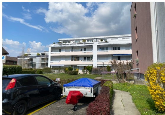
Unmittelbare Umgebung nördlich vom Perimeter
